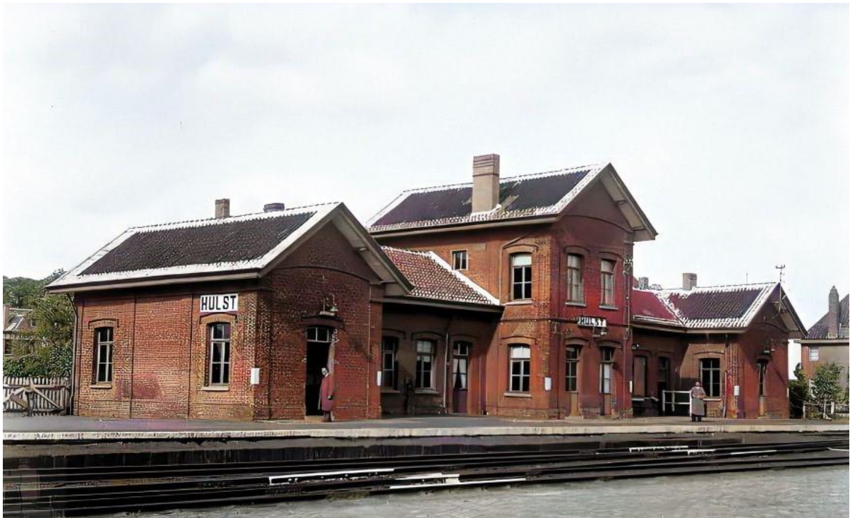
De perronzijde van station Hulst aan de spoorlijn Mechelen - Terneuzen. De spoorlijn wordt geëxploiteerd door de Société du Chemin de fer international de Malines à Terneuzen. 1946 Fotograaf: Bonthuis, J.A.
