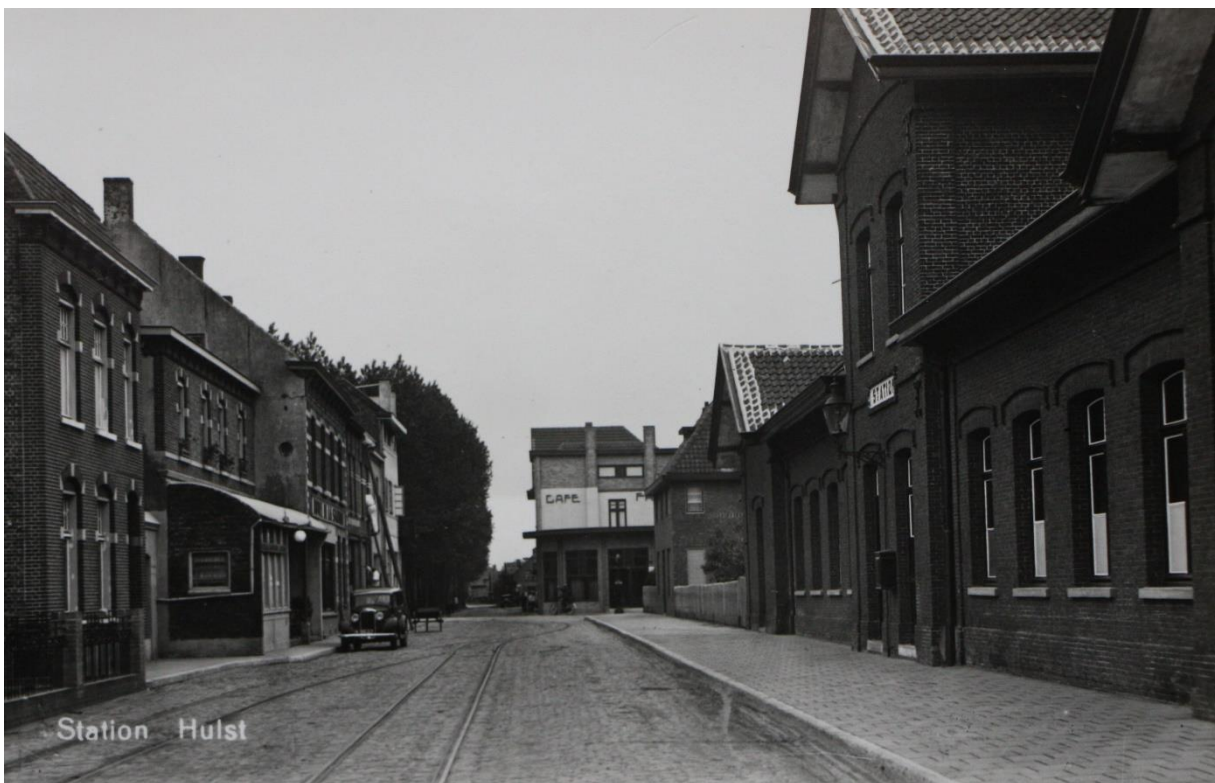
Station Hulst aan de straat- en tramzijde
